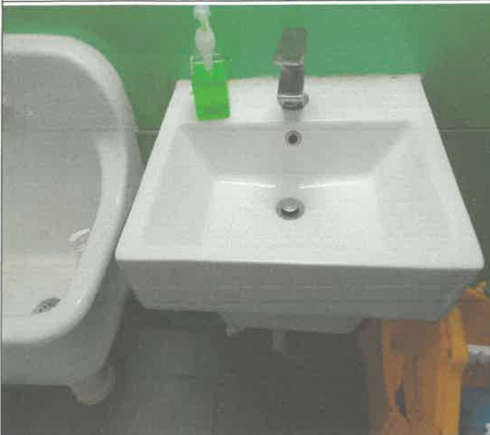
지하 1층 여자 화장실 세면대 막힘 통수
