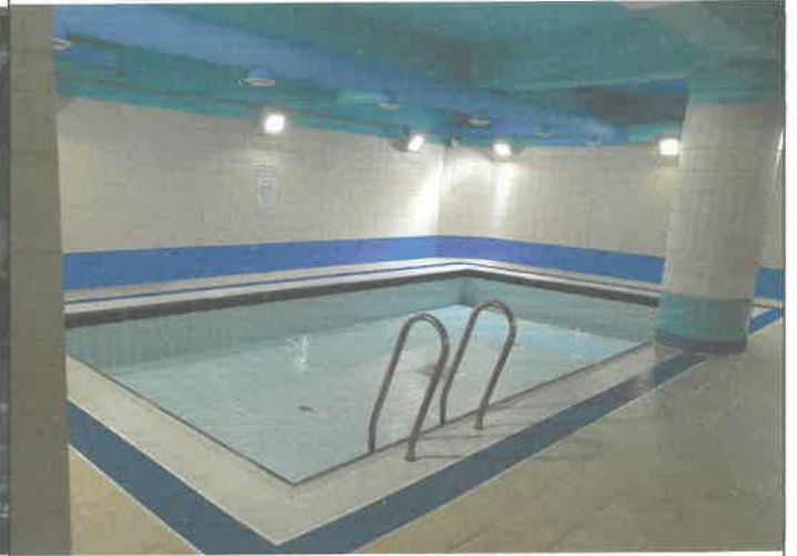
수영장 유아풀 배기 덕트 및 천장 페인트 칠
