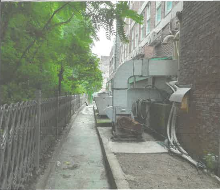
수영장 샤워실 배기팬 벨트교체
