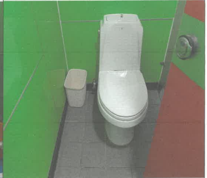
1층 여자 화장실 변기 막힘 통수
