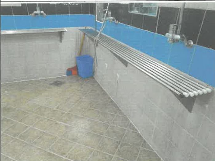
수영장 남자 샤워실 비누받침 환봉 탈락 전기 용접수리
