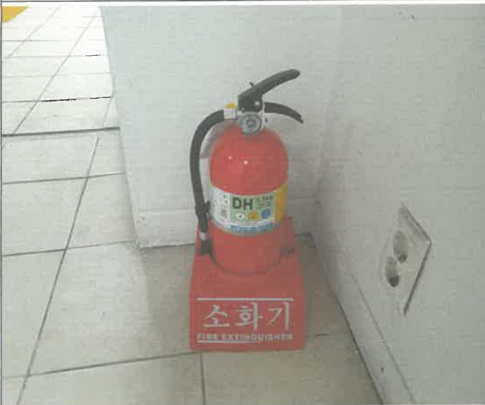
소화기 교체(소체육관 정문, 수영장 임대 락카룸, 남자 샤워장 입구) 3개소
