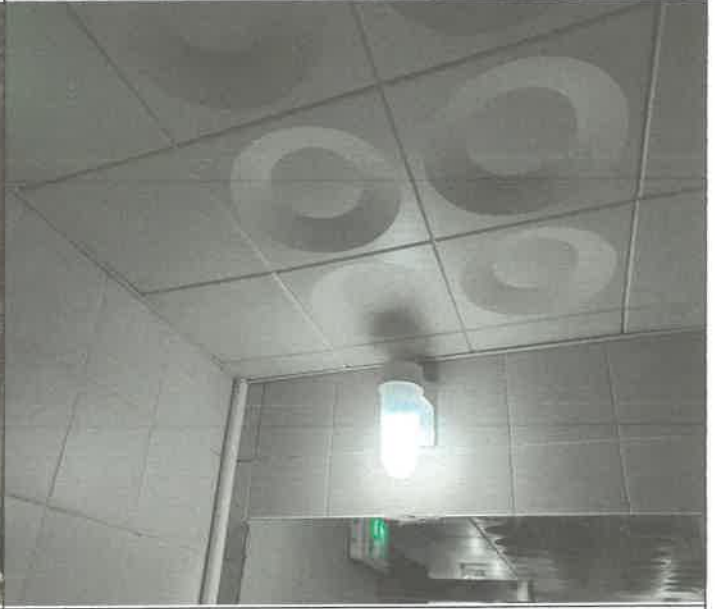
수영장 여자 샤워장 내 벽 등 1개소 탈거 되어 제설치 및 전구 1개 교체
