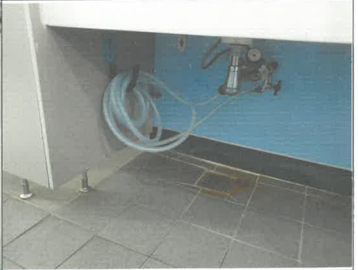
3층 남자 화장실 청소기용 호수 누수 보수
