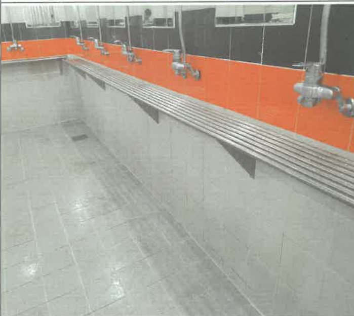
수영장 여자 샤워실 비누받침대 용접탈락 전기 용접 수리
