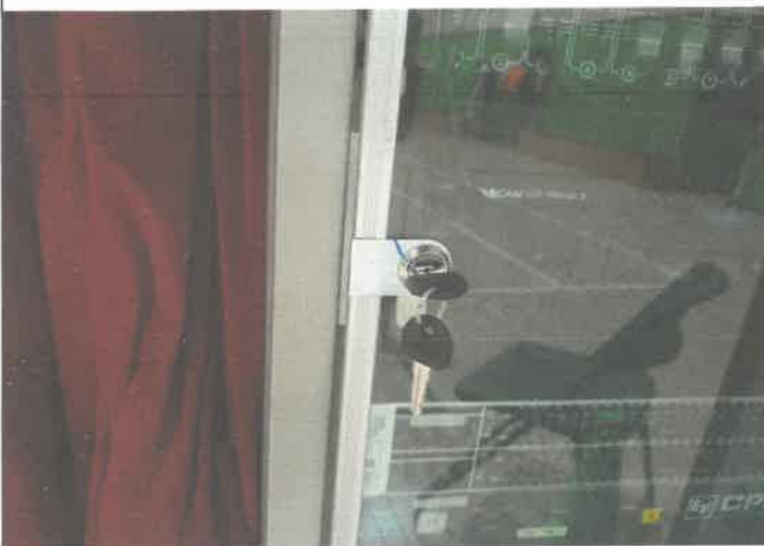
대체육관 엠프 시건 장치 설치
