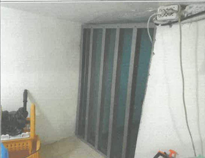
지하 비트 층 출입문 탈거 되어 제 설치 및 방충망 교체
