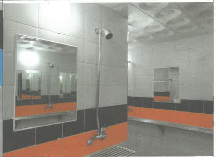
수영장 여자 샤워장 내 샤워기 수전 1개소 교체
