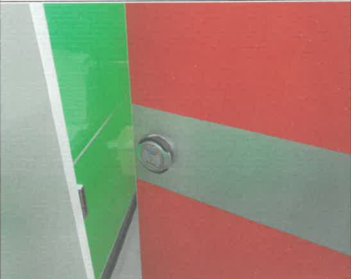
지하 1층 여자 화장실 대변기 문 잠금장치 파손 1개소 교체
