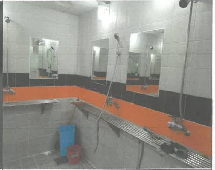
수영장 여자 샤워장 내 코브라 샤워기 호스 파손되어 교체 1개소
