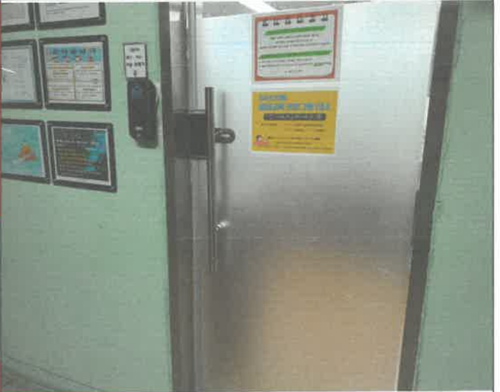
1층 평생 교육팀 출입문 손잡이 교체
